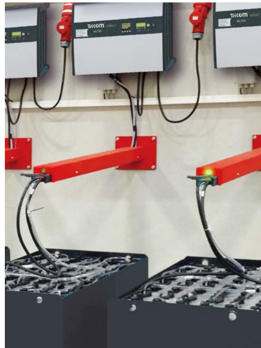
Beispiel: LED eingebaut, in der Dockingstation integriert
